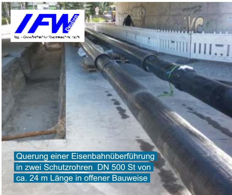
Querung einer Eisenbahnüberführung in zwei Schutzrohren DN 500 St von ca. 24 m Länge in offener Bauweise
