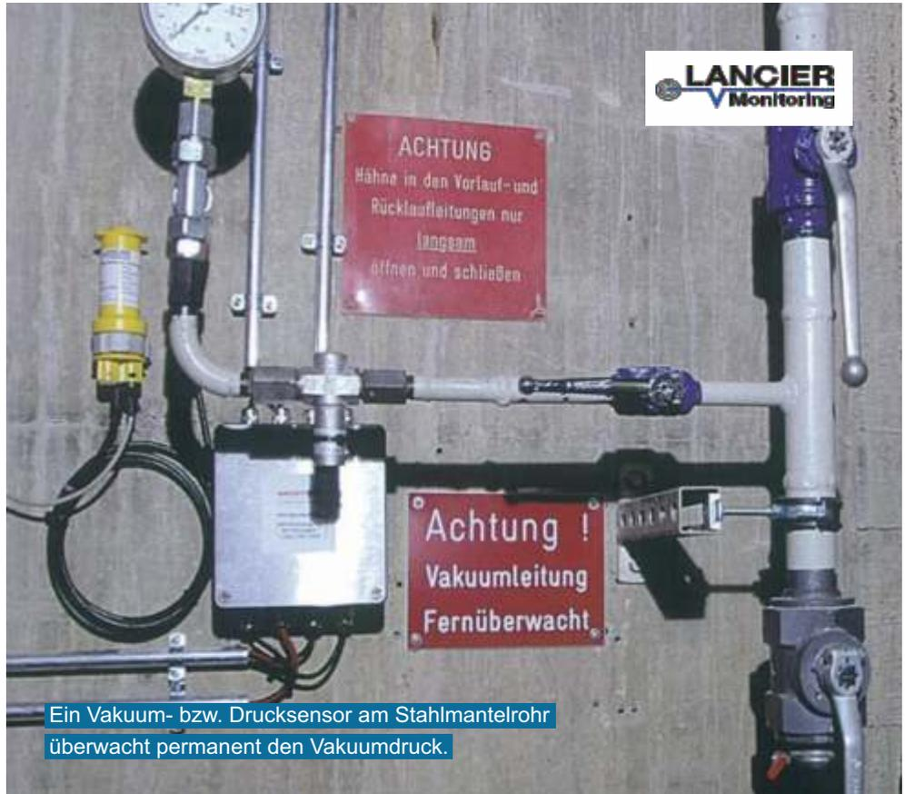
Ein Vakuum- bzw. Drucksensor am Stahlmantelrohr überwacht permanent den Vakuumdruck.
