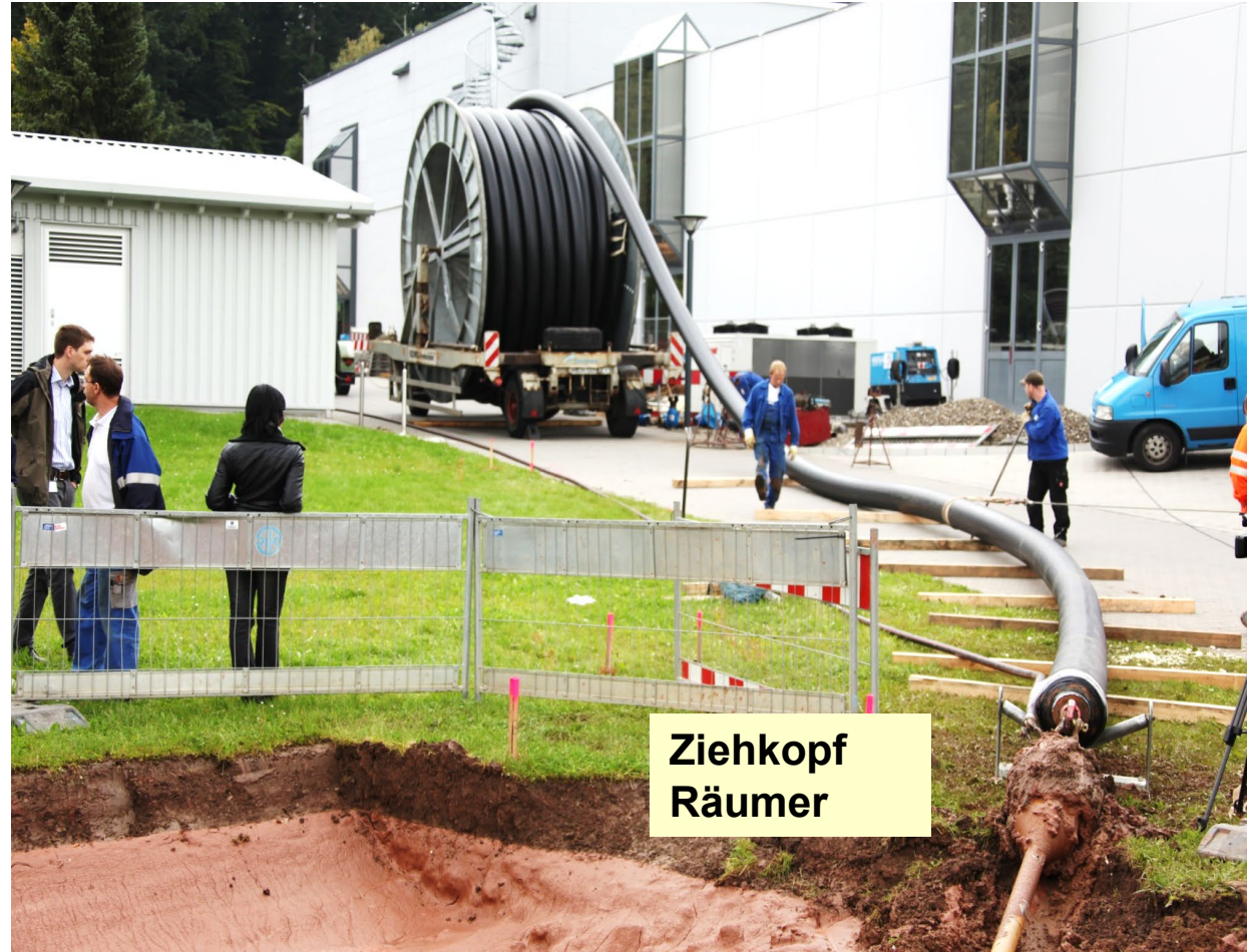
Bohranlage während des Ziehvorganges an der Startgrube
