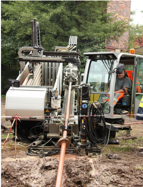
Bohranlage während des Ziehvorganges an der Startgrube
