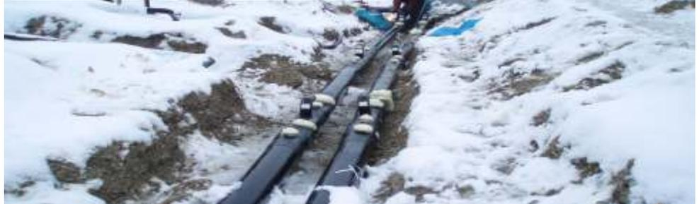
Generell müssen die Oberflächen der Stahlrohrverbindungen und der Mantelrohringraum der Muffenverbindung über die gesamte Dämm- und Dichtphase sicher auf Temperaturen zwischen +5°C und +45°C gehalten werden.
