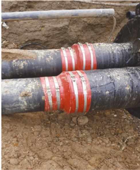
Abbildung 95, Abdichtung Hülrohr zum Mantelrohr mit Gelenkbolzenband
