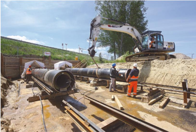
Abbildung 96, Verlegung von Stahlmantelrohren
