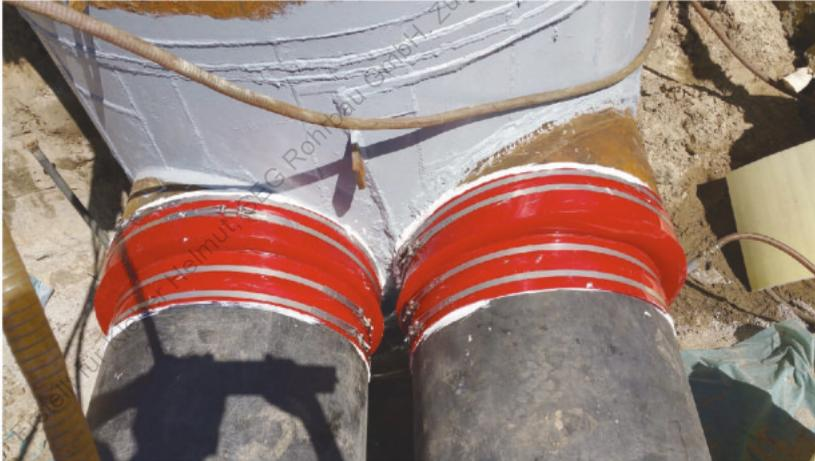
Abbildung 94, Beispiel einer KMR-Bauwerkseinführung
