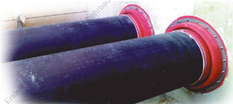
Abbildung 93, Beispiel einer Schachteinführung mit Abdichtmanschette vor der Wand
