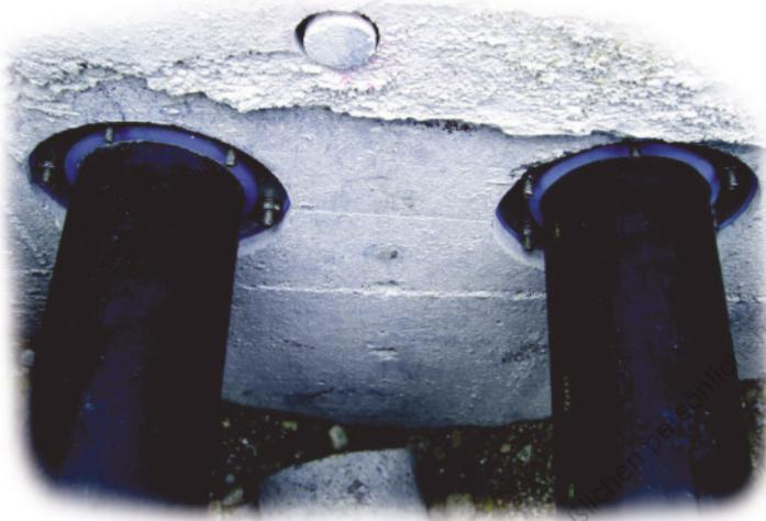
Abbildung 89, Beispiel Hausanschluss mit Ringraumdichtungen
