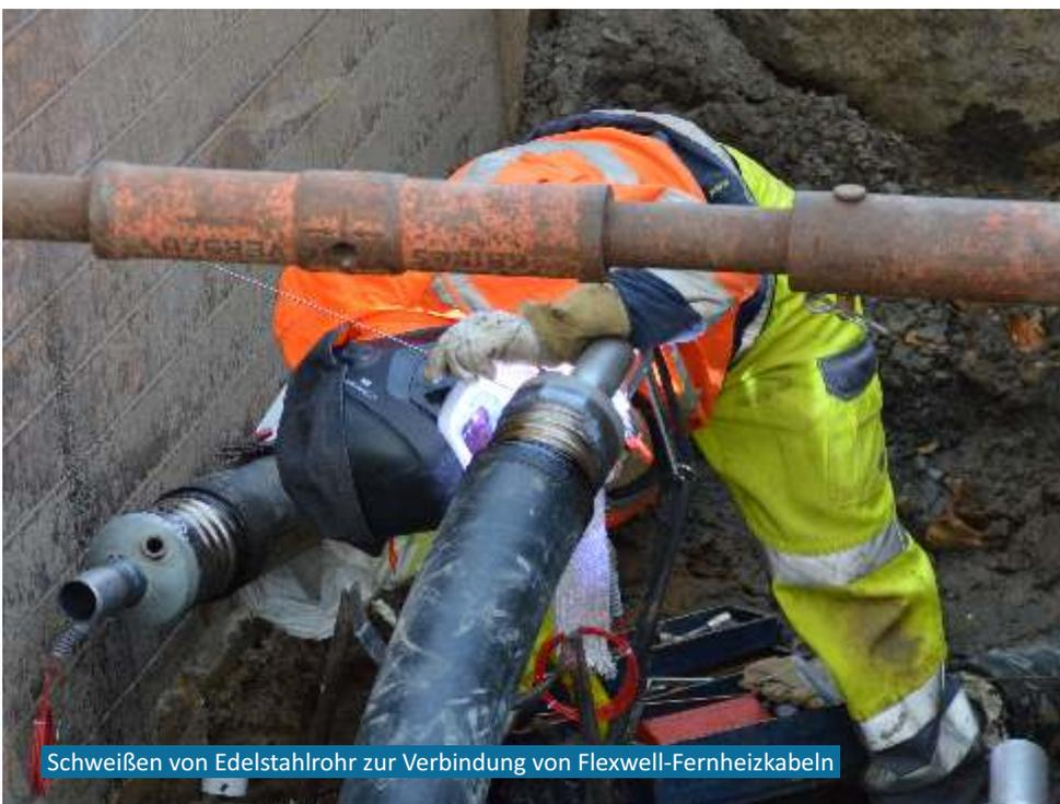
Schweißen von Edelstahlrohr zur Verbindung von Flexwell-Fernheizkabeln
