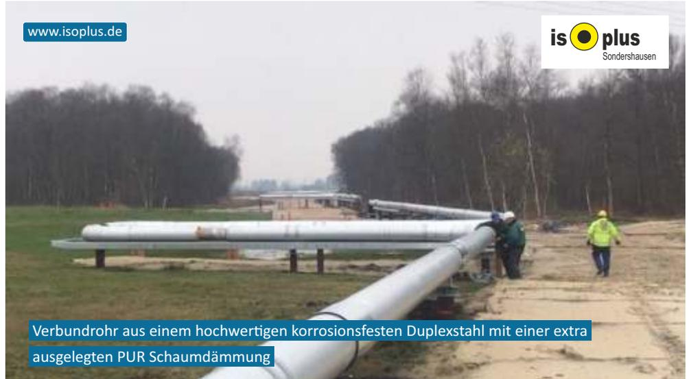
Verbundrohr aus einem hochwertigen korrosionsfesten Duplexstahl mit einer extra ausgelegten PUR Schaumdämmung
